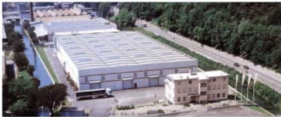
L'isola di saldatura ABB e lo stabilimento in cui è installata
