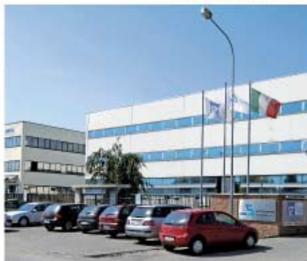
Esterno dello stabilimento GFG Group Srl di Robassomero (TO)
